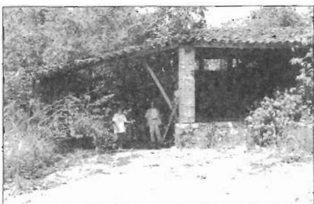
Fig. 4 - Segundo andar da caieira do Meio destacando a plataforma que facilitava o transporte da cal. Note ainda a presença da cobertura de telhas (FONTOURA et al. , 1999).
